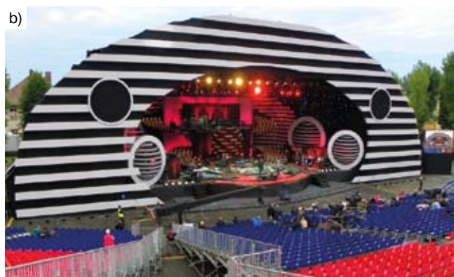
Rys. 19. Obiekty wykonane z elementów rusztowań, a) Łódź, fot. z archiwum firmy Altrad-Mostostal, b) tymczasowy amfiteatr i trybuna w czasie 47 KFPP w Opolu
