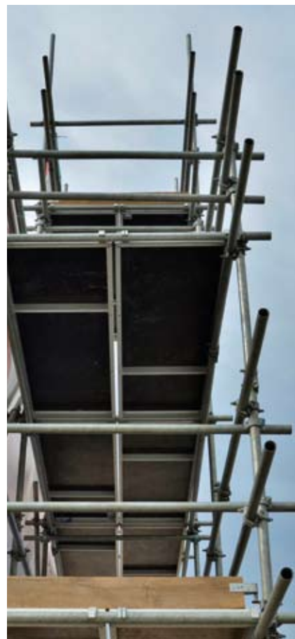
Przykład konstrukcji rusztowania rurowo-złączkowego
