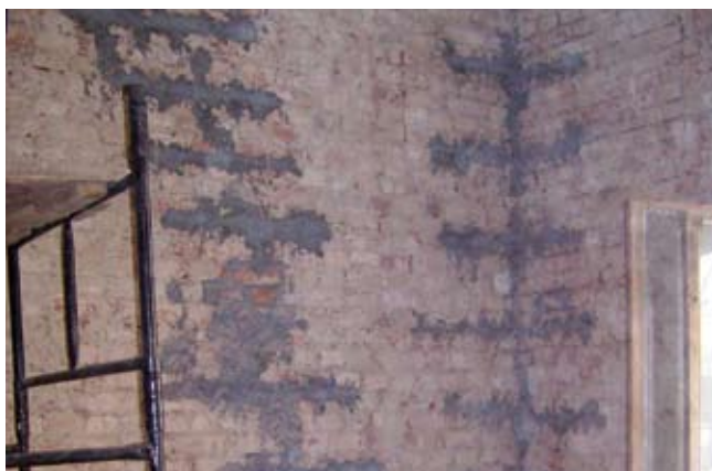
Rys. 15. Naprawy spękań muru, fot. J. Misiewicz, 2007
