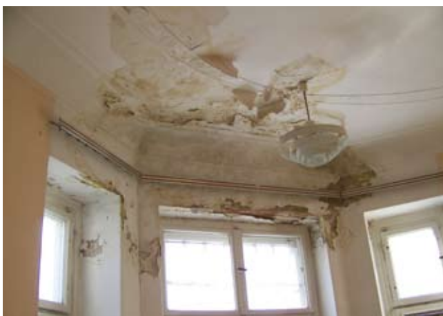
Rys. 11. Szkody spowodowane przeciekami, fot. J. Misiewicz, 2007
