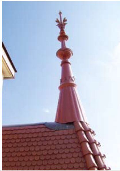
Rys. 20, 21. Dachy pokryte dachówką karpówką, fot. J. Misiewicz, 2008
