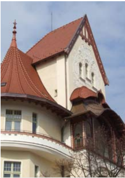
Rys. 20, 21. Dachy pokryte dachówką karpówką, fot. J. Misiewicz, 2008
