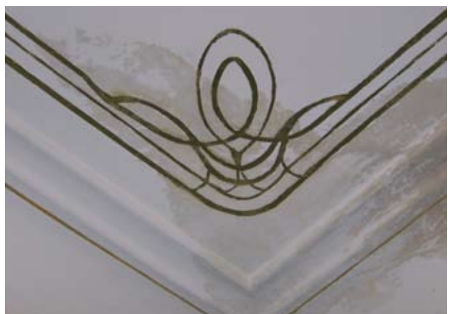
Rys. 12. Błędnie odtworzone złozenia podczas remontu w 2004 roku, fot. J. Misiewicz, 2007
