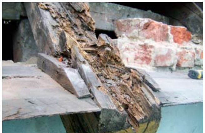
Rys. 10. Zniszczony fragmentu krokwi w wyniku działania owadów i grzybów, fot. J. Misiewicz, 2007
