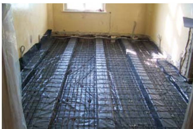
Rys. 18. Prace wzmocniające stropu drewnianego, fot. J. Misiewicz, 2007
