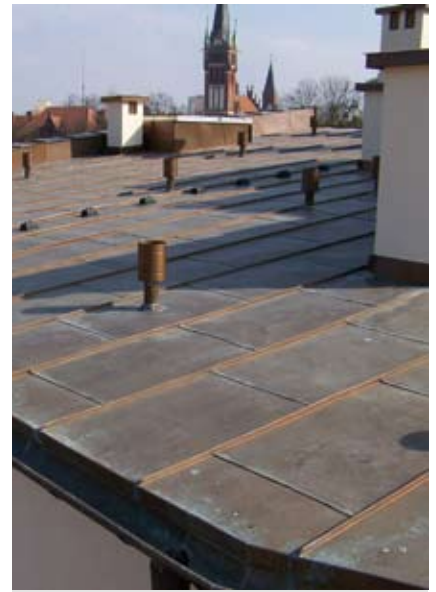
Rys. 22. Dachy płaski pokryty blachą miedzianą, fot. J. Misiewicz, 2008
