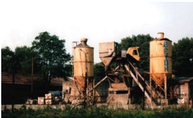
Rys. 1. Betoniarnia starszej generacji
