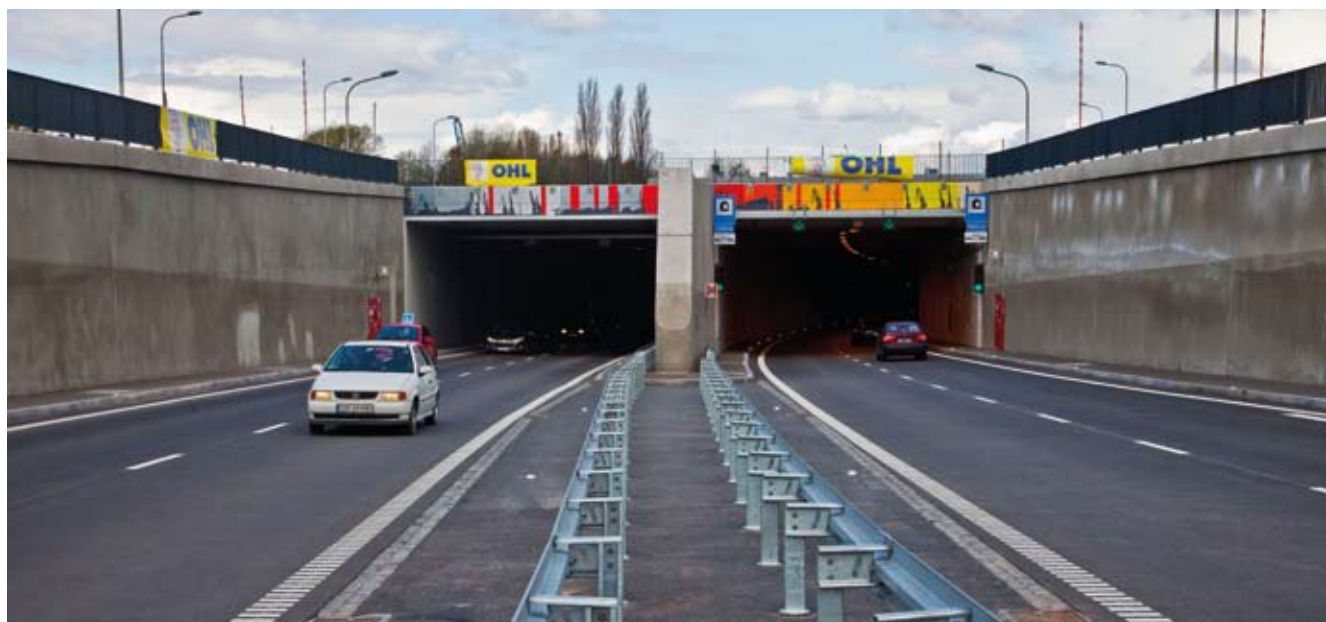
Wjazd i wyjazd do/z tunelu od strony węzła Marynarki Polskiej
