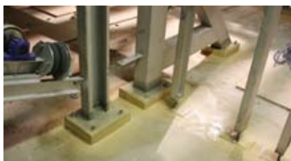
Ochrona posadzki betonowej i konstrukcji stalowej
