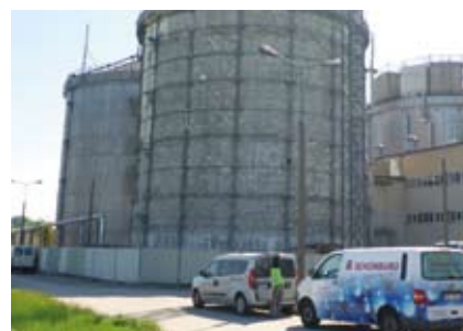
Oczyszczalnia ścieków Lublin
