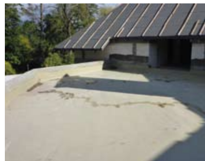
Paroizolacja taras Warszawa
