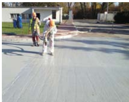
Zabezpieczenie nawierzchni drogowej PKN Orlen
