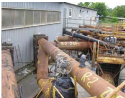
Instalacja przesyłowa KGHM Rudna
