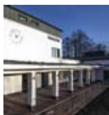
Budynek Dworca Kolejowego, Piaseczno, ul. Dworcowa – zwycięzca w kategorii IV: Budynek niemieszkalny, fot. fasadaroku.pl
