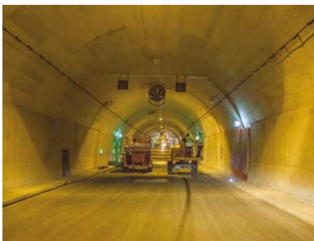
Tunel – montaż tablic kierunkowych
