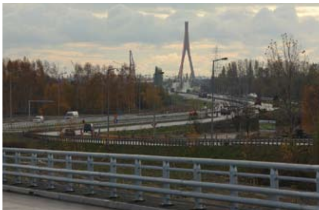
Trasa Sucharskiego – zadanie II – wjazd na most wantowy
