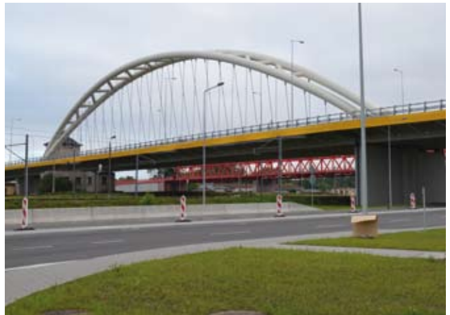
Trasa Słowackiego – zadanie III – wiadukt nad torami kolejowymi do portu
