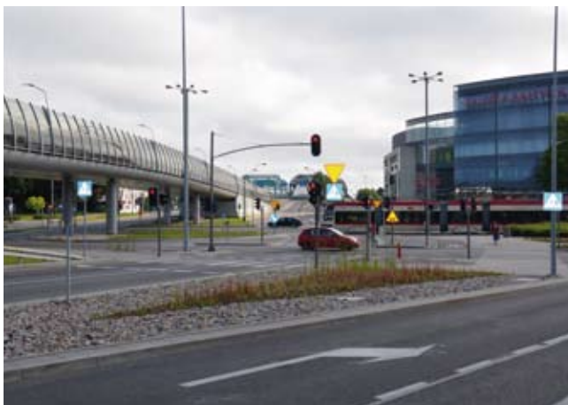
Trasa Słowackiego – zadanie II – estakada nad al. Grunwaldzką
