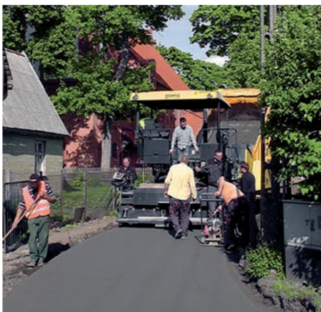
Rys. 6. Rozścielacz BOMAG BF800C w trakcie układania nawierzchni z betonu wałowanego (źródło: Firma Harat S.J.)
