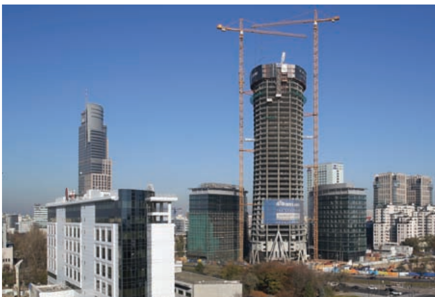
Warsaw Spire w Warszawie (u góry widoczne osłony RCS-P)
