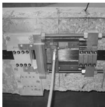
Rys. 3. Czynna strona systemu kotwiąco-sprężającego Sika® LEOBA CarboDur® SLC II [15]
