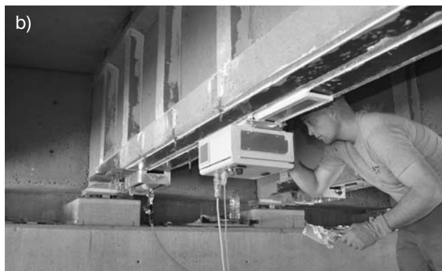
Rys. 10. Bezkrotowy system naprężania ze stopniową redukcją siły naciągu w taśmie: a) w laboratorium Empa, b) na moście w Szczercowskiej Wsi [26]
