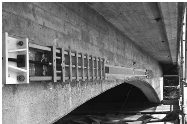
Rys. 11. Bezkrotowy system naprężania Tenroc podczas wzmocniania mostu przez rzekę River Nossan w Szwecji [27]
