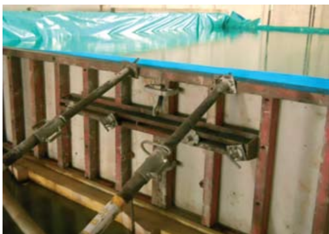
Rys. 1. Ściana basenu napełnionego wodą, za pomocą którego realizowano obciążenie próbne
