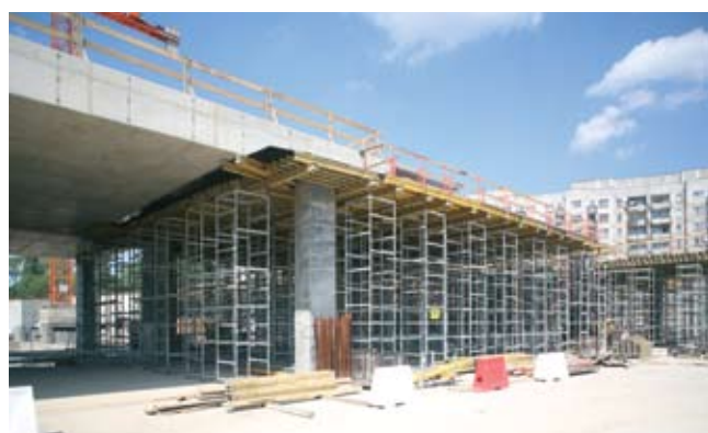
Wieża ST 100 jako podparcie stropów. Wysoka nośność i możliwość montażu wież bez stężeń skróciły czas montażu i nakłady pracy na późniejsze rozdeskowanie
