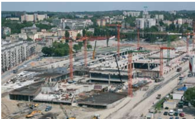
Widok na plac budowy nowego dworca Łódź Fabryczna
