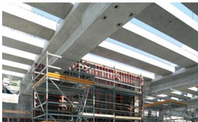
Rusztowania zbrojarskie i platformy betoniarskie PERI UP Rosett wyposażone zostały w kółka umożliwiające łatwe przestawianie bez konieczności używania żurawia
