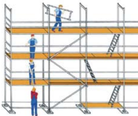
Rys. 1. Montaż rusztowań z użyciem transportu ręcznego. Źródło: Mat. szkol. Bundesinnung für das Gerüstbauer-Handwerk
