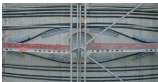
Rys. 10. Układ stalowych dewiatorów przy otworze technologicznym
