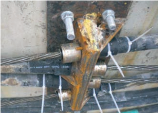
Rys. 11. Zabezpieczenie antykorozyjne przestrzeni między blachami oporowymi
