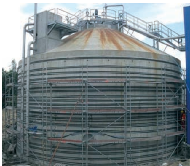
Rys. 9. Rozmieszczenie cięgien sprężających na wysokości ściany zbiornika
