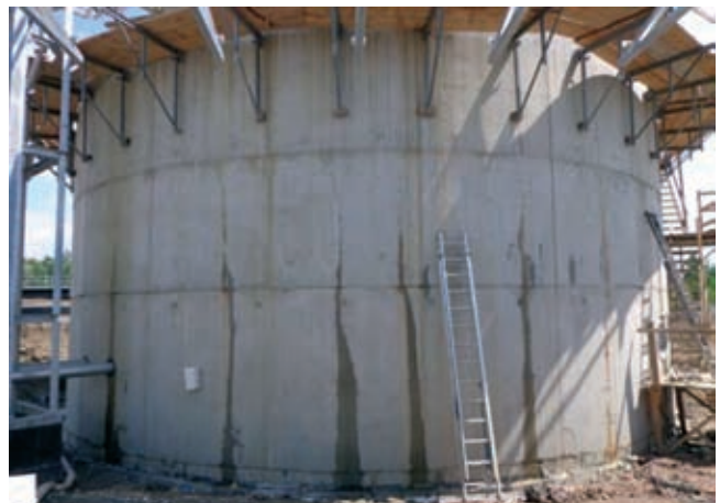
Rys. 2. Przecieki na ścianie zbiornika WKF przy słupie cieczy 5,5 m
