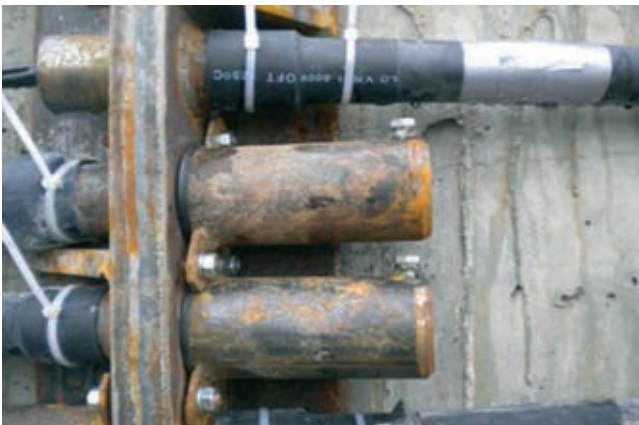
Rys. 12. Uszczelnienie styku zabezpieczającego kotłaka z blachą oporową
