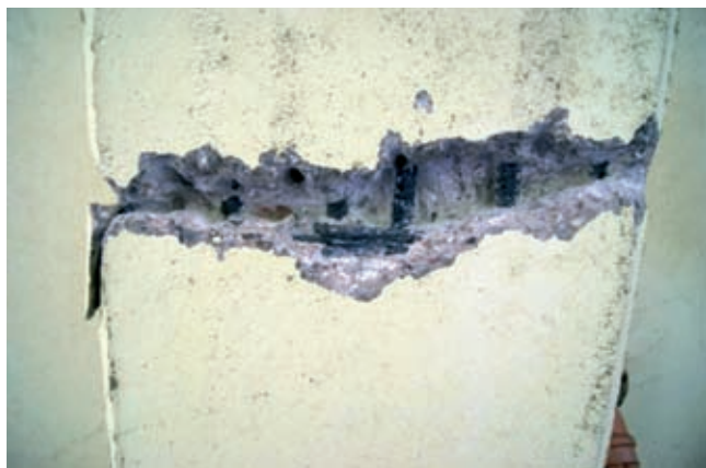
Rys. 1. Przykładowa odkrywka zbrojenia w poprzek całej szerokości belki
