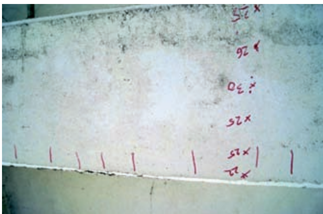
Rys. 2. Przykładowe rozpoznanie układu zbrojenia skanem bez możliwości rejestrowania
