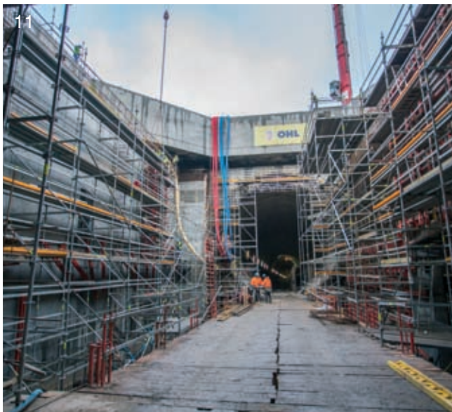
7-10. Budowa konstrukcji jezdni wewnątrz tunelu; 11-12. Rusztowania do prac wykończeniowych
