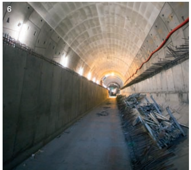
1-5. Budowa przejść poprzecznych pomiędzy rurami tunelu; 6. Montaż obudowy p.pożarowej na stropie tunelu
