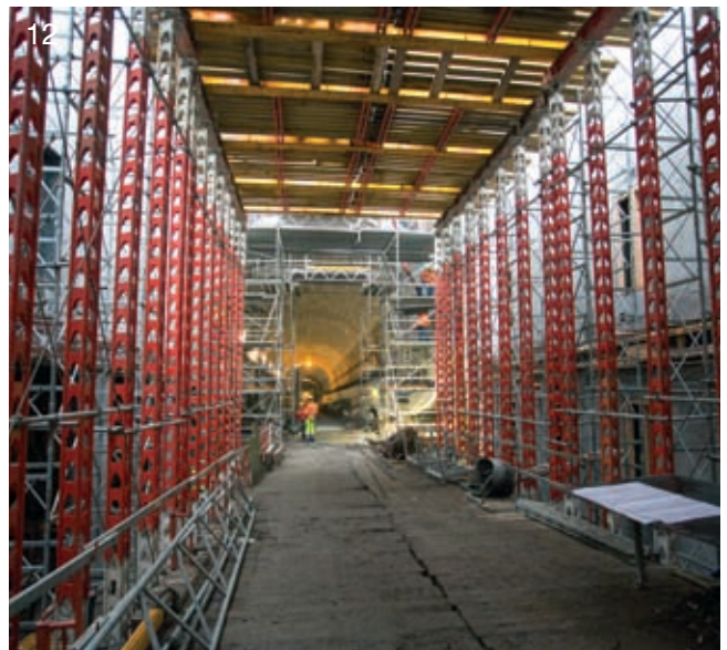
7-10. Budowa konstrukcji jezdni wewnątrz tunelu; 11-12. Rusztowania do prac wykończeniowych
