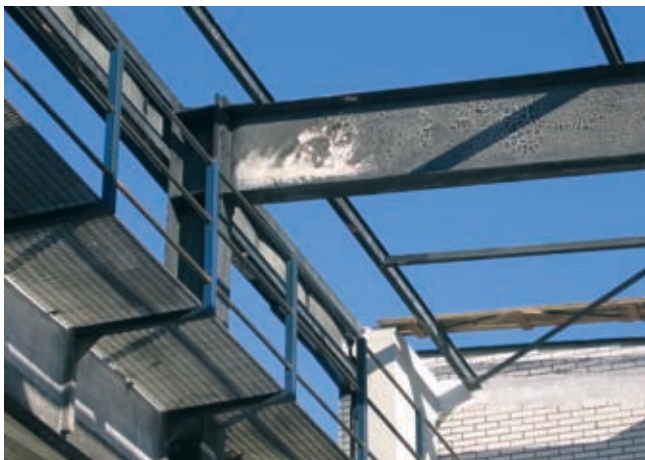
Rys. 7. Etapy odbudowy stalowej konstrukcji przekrycia dachowego
