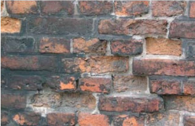
Rys. 5. Widok muru ceglanego uszkodzonego wskutek korozji mrozowej [1]
