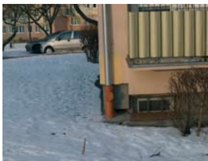
Rys. 11. Liniowy mostek termiczny – pasmo cokołu (foto archiwum autora)
