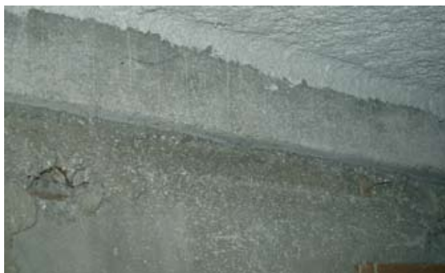
Rys. 9b. Podczas modernizacji termicznej budynków systemu OWT-67 (wspomagającej metodą lekką-mokrą zastosowaną na zewnątrz budynku) zastosowano wewnątrz (w płaszczyźnie stropu nad nieogrzewaną piwnicą) metodę natryskową izolacji termicznej. Brak izolacji w płaszczyźnie pionowej domykającej mostek liniowy (foto archiwum autora)
