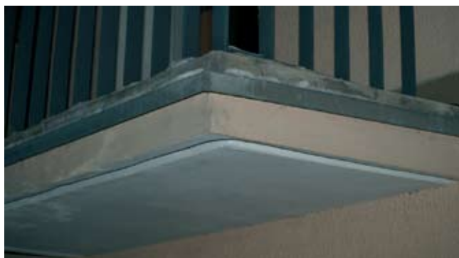
Rys. 9a. Podczas modernizacji termicznej budynków systemu OWT-67 metodą lekką-mokrą nie dokonano likwidacji strat ciepła poprzez mostek liniowy, tworzący żyłkę termiczną (foto archiwum autora)
