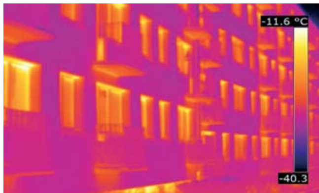
Rys. 6. Problem strat energii poprzez liniowe mostki termiczne. Żyłka termiczna powstała w płycie wspornikowej systemu balkonu oraz straty w obrębie płaszczyzny kondygnacji stropu nad piwnicą (foto archiwum autora)
