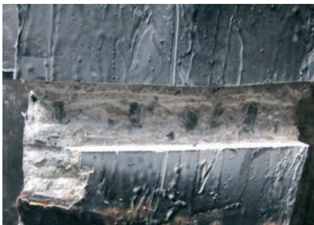
Rys. 5. Odkrywka zbrojenia dolnego podciągu
