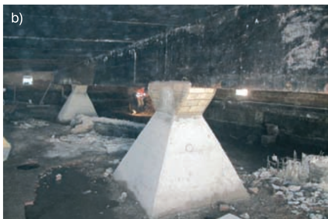
Rys. 6. Wzmocnienie płyty fundamentowej: a) dokumentacja robocza, b) widok zrealizowanego wzmocnienia
