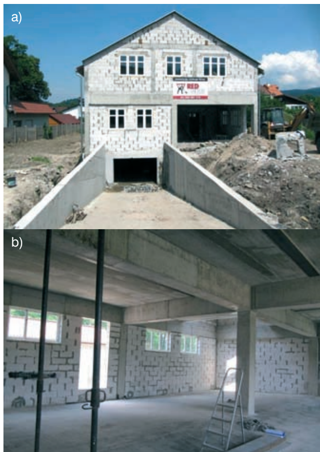
Rys. 7. Stan surowy zamknięty: a) widok od frontu, b) widok wnętrza
