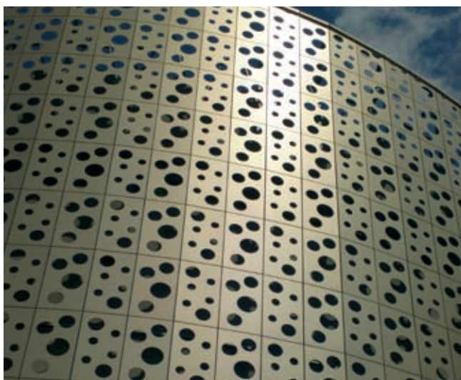
Rys. 11. Galeria Korona w Kielcach – fasada z perforowanych płyt kompozytowych alucobond (fot. autora)
