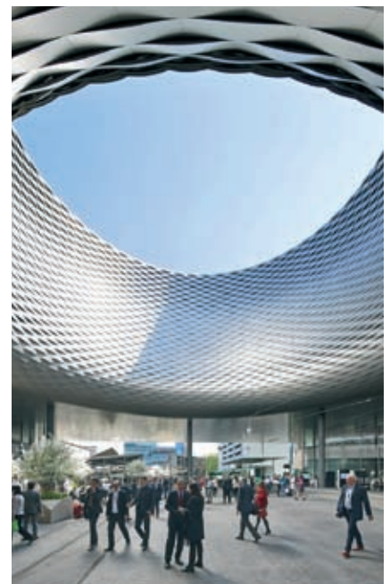
Rys. 8. Atrium centrum wystawowego New Hall Messe w Bazylei – widok ogólny [10]
