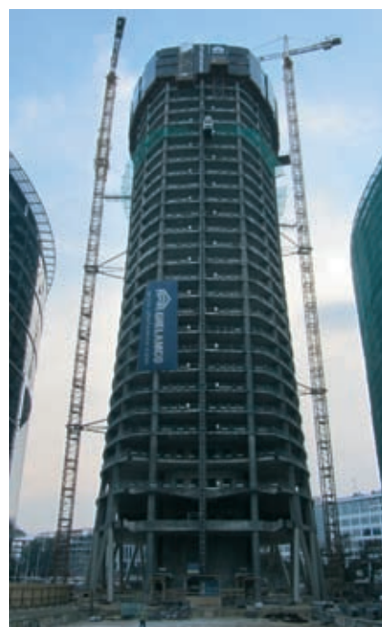
Rys. 6. Budynek wieżowy w budowie; stan z października 2014
