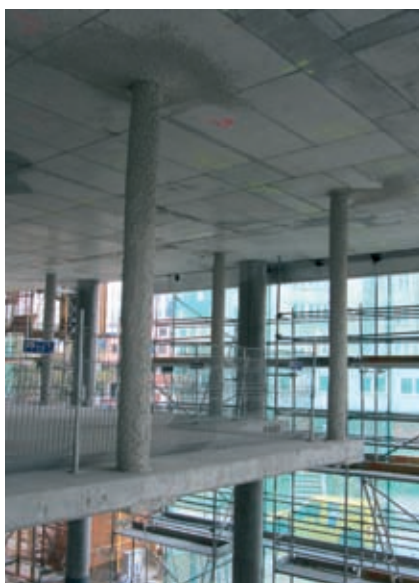
Rys. 4. Fragment płyty stropowej wraz z mocującymi ją wieszakami
