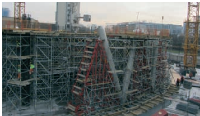
Rys. 2. Stupy V w budowie; stan z grudnia 2013 roku
