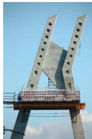
Widok na pomost pośredni pylonu obiektu 4.2
