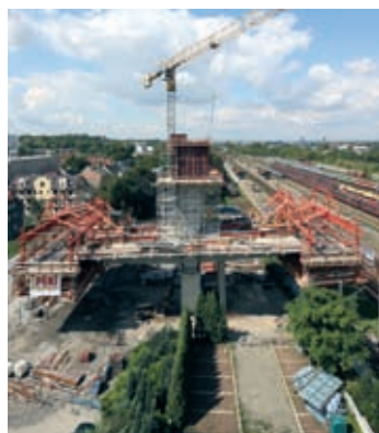
Widok na podporę siódmą z trawelerami PERI BCC
