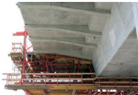
Wspornik estakady z poprzecznym uźebrowaniem
