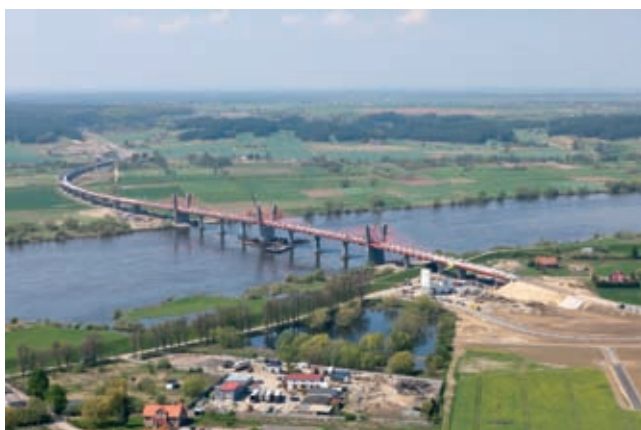
Most przez Wisłę koło Kwidzyna w trakcie budowy
