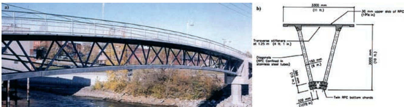
Rys. 2. Kładka pieszo-rowerowa w miejscowości Sherbrooke w Kanadzie [2]: a) widok, b) przekrój poprzeczny przęsła
