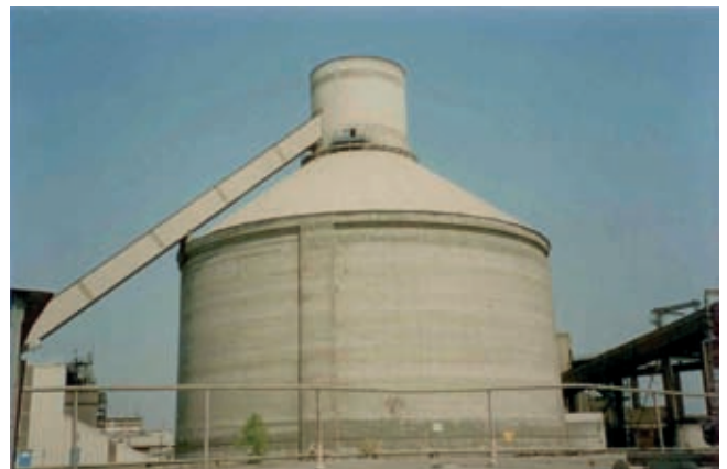
Rys. 3. Widok silosu klinkieru
