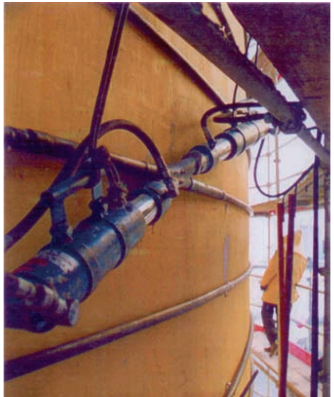
Rys. 4. Sprężanie płaszcza silosu kablami Freyssineta z zastosowaniem zakotwienia krzyżowego typu X
