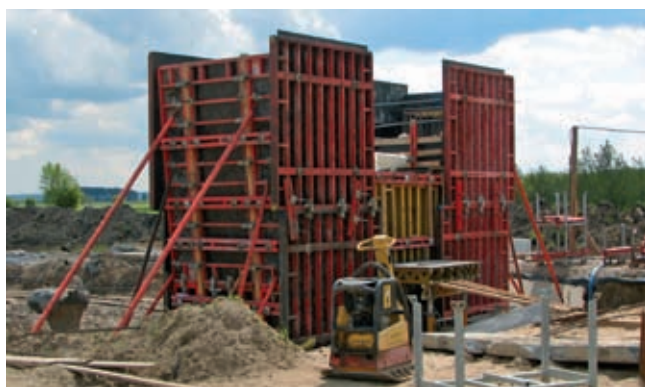
Fot. 5. Deskowanie typowej podpory estakady E1.
