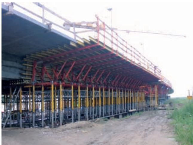
Fot. 1. Deskowanie ustroju nośnego estakady E1
