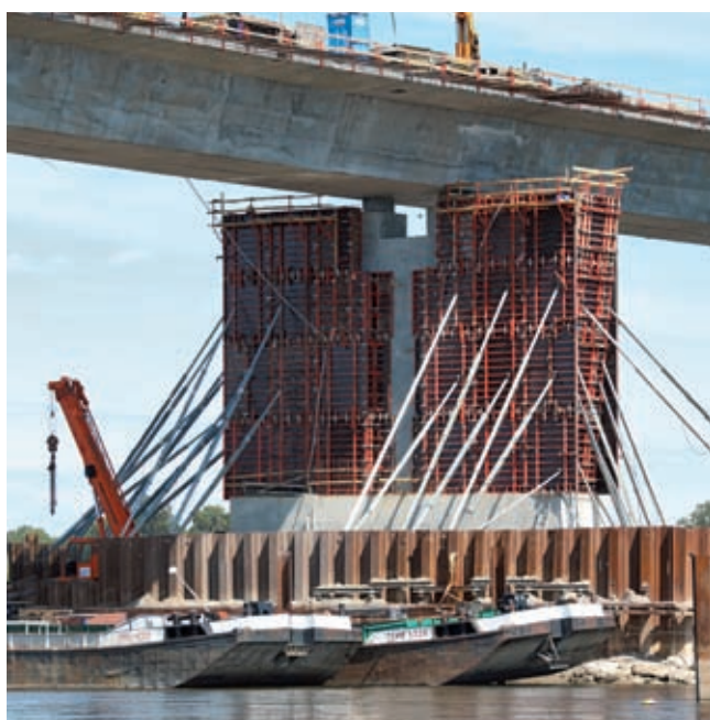
Fot. 6. Widok przykładowego filara mostu M4 przed III etapem betonowania
