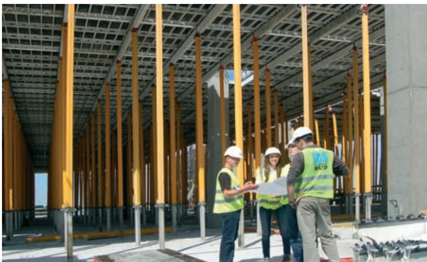
Deskowanie stropowe SKYDECK charakteryzuje się małą liczbą elementów, co wiąże się z szybszą i sprawniejszą logistyką
