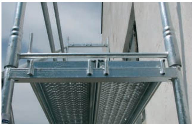
Fot. 2. Zabezpieczenie pomostu przez ramę wyższej kondygnacji
