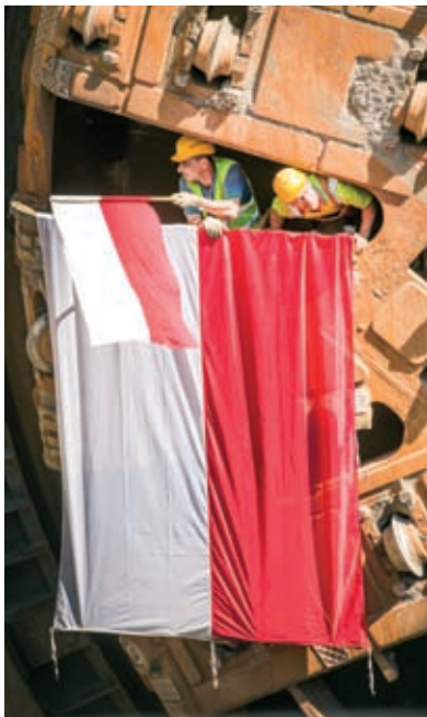
Zadowolenia z zakończenia wiercenia nie ukrywają jego wykonawcy
