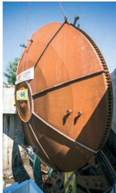
Podniesienie stalowego „kapelusza” odsłoniło tarczę maszyny TBM
