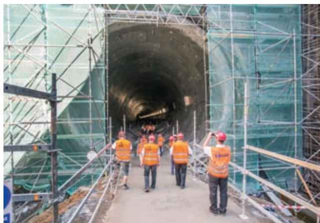
Wejście do wydrążonej drugiej rury tunelu
