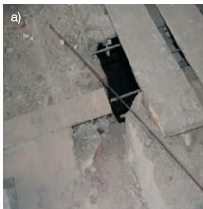
Rys. 1. Strop nad parterem: a) oparcie stropu korytarza na ścianie wewnętrznej nośnej, b) pęknięcie na górnej powierzchni stropu korytarza
