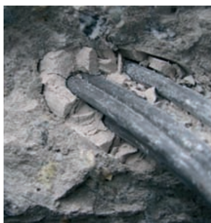
Fot. 2. Widok kanału kablowego wypełnionego iniekcją
