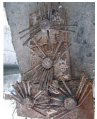
Fot. 1. Widok bloków kotwiących kable sprężających
