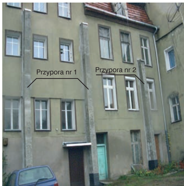
Rys. 3. Elewacje budynków od strony podwórza i usytuowanie zaprojektowanych podpór ściany. Zrealizowane przypory
