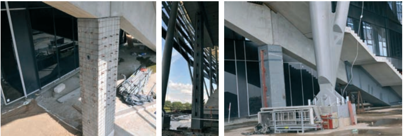
Rys. 11. Stalowe wzmocnienia schodów w trakcie realizacji (zdjęcia autorów)
