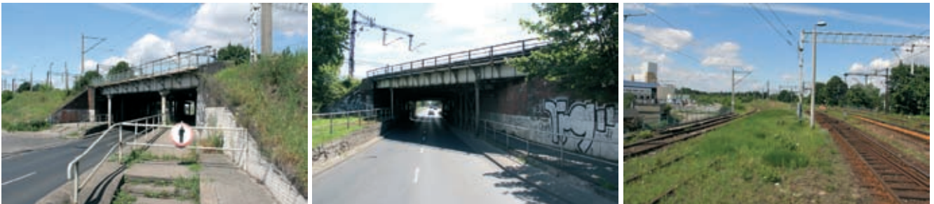
Rys. 1. Widok ogólny wiaduktu
