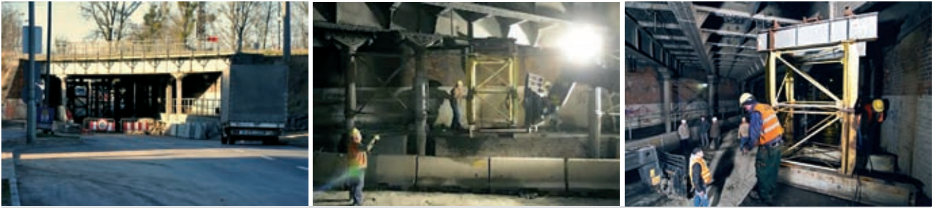
Rys. 9. Zabezpieczenie obiektu – tymczasowe podparcie konstrukcji przęseł [7]
