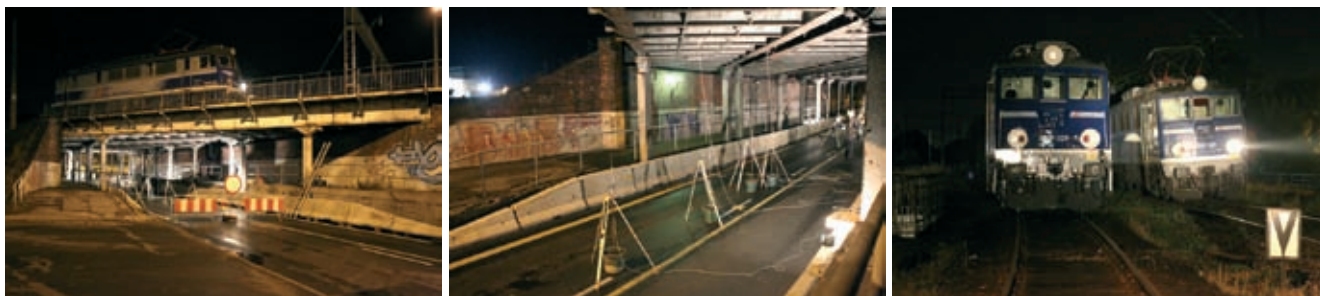
Rys. 6. Próbné obciążenie obiektu
