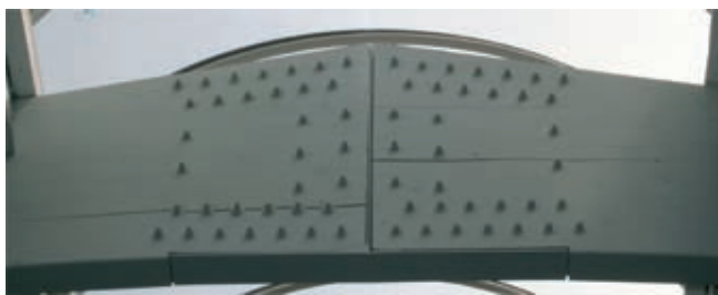
Rys. 2. Węzeł kalenicowy
