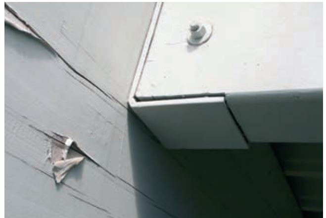
Rys. 6. Połączenie tężnika z rygłem. Widoczne spękania rygla oraz łuszczenie się powłoki malarskiej
