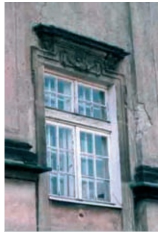
Rys. 7. Opaski okienne kamienicy pod Srebrnym Helmem, stan przed remontem, fot. A. Konieczny
