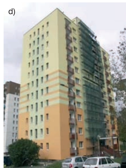
Rys. 3. Przykłady modernizacji budynków wielkopłytowych: a) wykonanie otworu w stropie dla wbudowania schodów kręconych do mieszkania dwupoziomowego [2], b) planowana nadbudowa budynku w systemie WBS 70/5 [2], c) wypełnienie luki między dwoma budynkami WBS 70 w Berlinie [2], d) docieplenie ścian 11-kondygnacyjnego budynku w Katowicach
