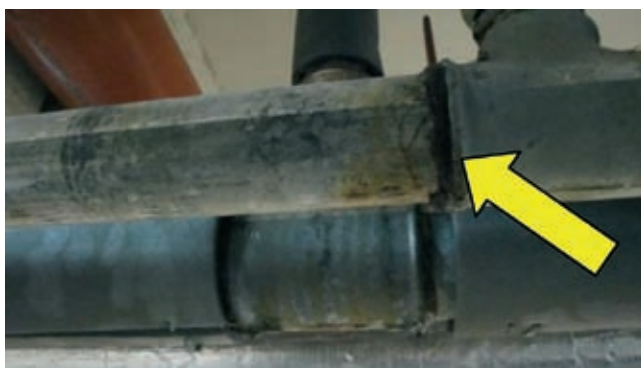
Rys. 6. Korozja w rurach z ciepłą wodą użytkową – okolice połączenia gwintowanego
