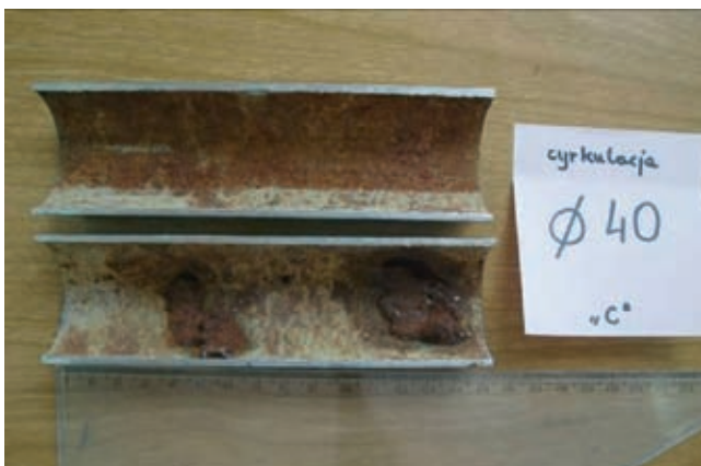
Rys. 4. Korozja rur ocynkowanych transportujących ciepłą wodę w systemie ogrzewania
