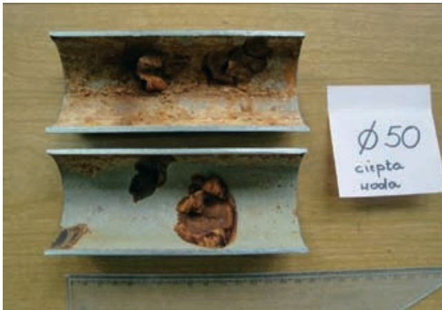
Rys. 3. Korozja rur ocynkowanych transportujących ciepłą wodę użytkową
