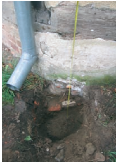
Rys. 2. Elewacja północno-zachodnia – fragment. Odkrywka fundamentu. Brak odsadзки fundamentu. Rura spustowa odprowadzająca wodę z dachu w bezpośrednim sąsiedztwie cokołu
