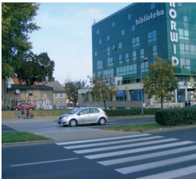
Fot. 5. Nieuporządkowany teren w bezpośrednim otoczeniu świeżo odnowionego budynku wywołuje wrażenie negatywne
