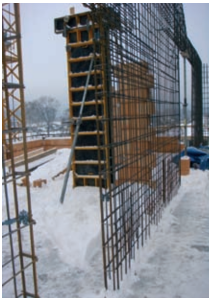
Rys. 3. Widok placu budowy w okresie zimowym w Gdańsku
