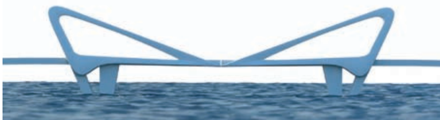
Rys. 7. Most zwodzony, wariant II, widok ogólny z boku, most opuszczony
