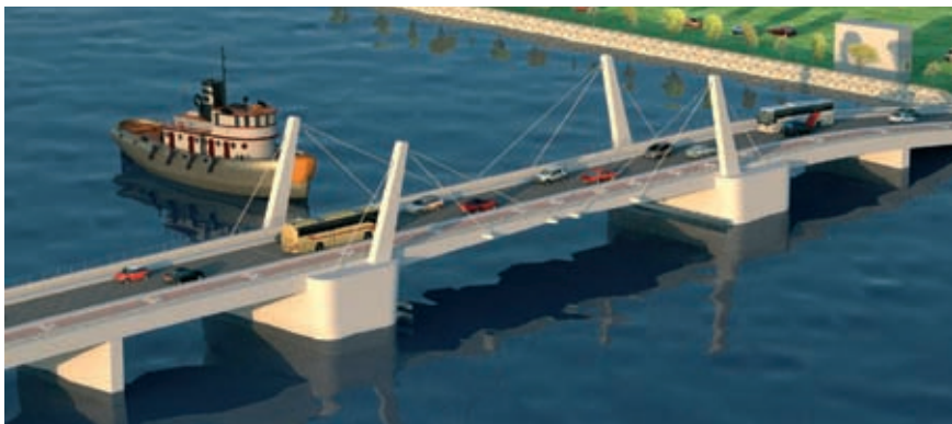
Rys. 18. Most zwodzony, wariant V, widok ogólny, most opuszczony
