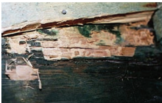
Rys. 6. Widok śladów mechanicznych szkodników drewna w odstąpiętej powierzchni belki oczepu
