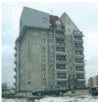
Fot. 10. Czechów, budynek wielkopłytkowy W-70 nadbudowany betonem komórkowym lub cegłą ceramiczną pełną i dachem o konstrukcji drewnianej
