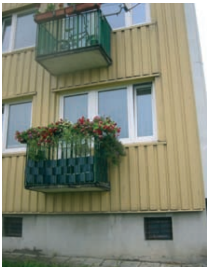
Fot. 6. Lublin, budynek wielkopłytowy, widok balkonu wspornikowego wg katalogu systemowego
