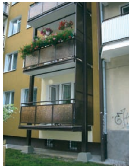
Fot. 8. Lublin, w płycie balkonowej zabetonowano nieodcięty balkon wspornikowy
