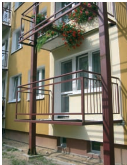
Fot. 7. Lublin, nieodcięty balkon wspornikowy w dostawionym szkielecie stalowym
