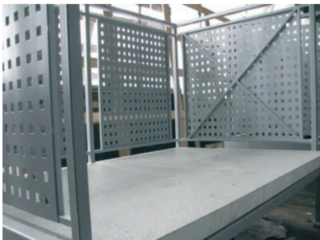
Fot. 2. Balkon podwieszany o konstrukcji stalowej z lekką płytą kompozytową pokrytą dwustronnie blachą aluminiową
