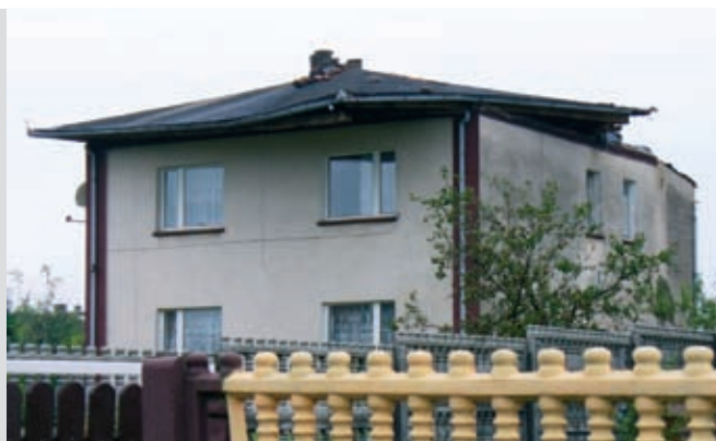
Rys. 4. Przemieszczenie dachu
