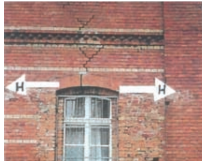
Fot. 1. Przykłady uszkodzeń nadproży łukowych usytuowanych przy ścianach szczytowych
