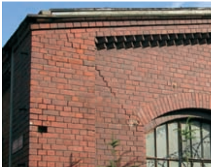
Fot. 1. Przykłady uszkodzeń nadproży łukowych usytuowanych przy ścianach szczytowych
