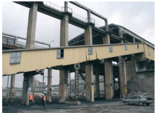
Rys. 1. Skład węgla w zachodniej części hali – widoczny obudowany taśmociąg zamocowany do słupów
