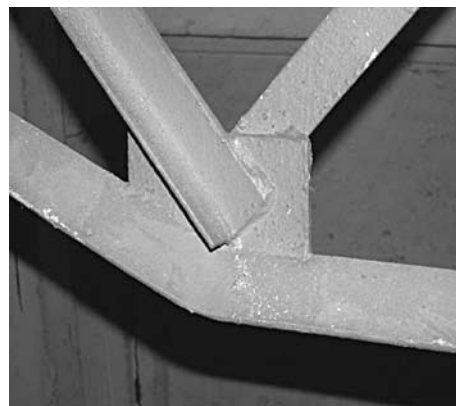
Rys. 8. Węzeł skrajny pasa dolnego
