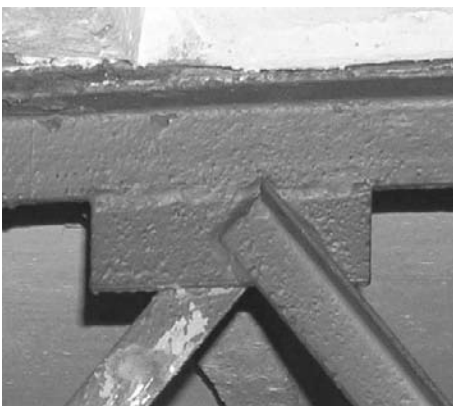
Rys. 7. Węzeł pośredni pasa górnego
