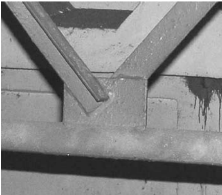
Rys. 6. Węzeł pośredni pasa dolnego
