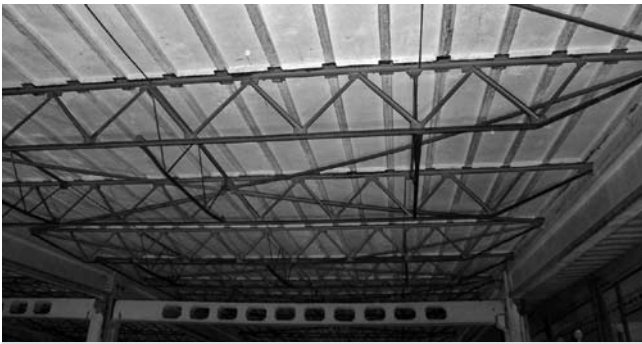
Rys. 3. Widok na płatwie kratowe dachu naw środkowych budynku rozdzielni
